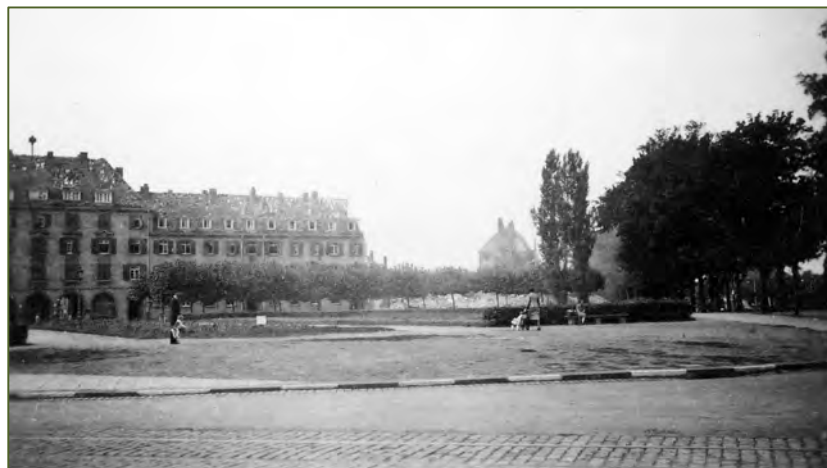
Abb. 26 Südwestseite des Fichteplatzes mit gusseisernen Laternen und Pflanzstreifen für Bäume, um 1928
