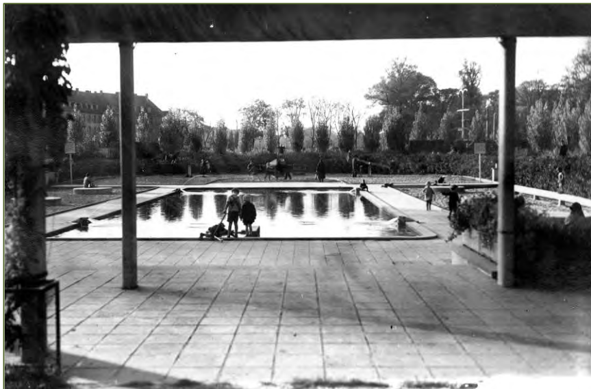
Abb. 42 Bau Des Planschbeckens und der Pergola, 1929/30
