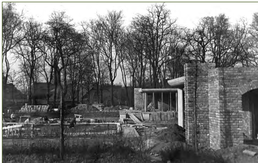
Abb. 188 Armiereisen auf dem geschwungenen Dach beim Pergolabau, 1929
