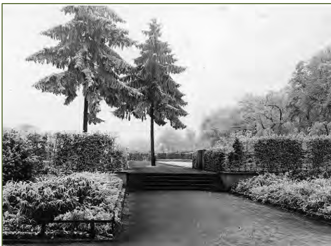
Abb. 206 Mittelachse des Blütengartens: wassergebundene Wegedecke mit schmalen Betonkantenstein, 1929-30
