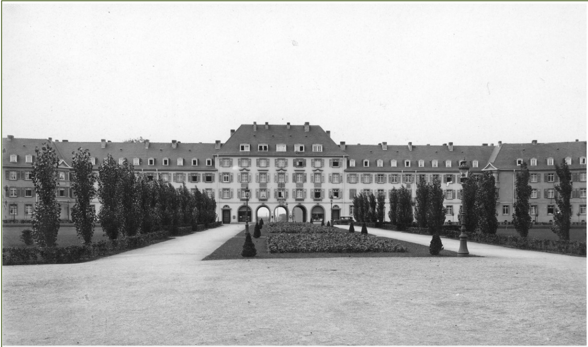
Abb. 252 Fichteplatz mit Häuserfront der Fichteplatzsiedlung nach der Fertigstellung August 1928
